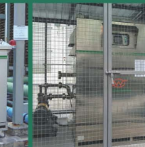
Energy Complex (ENCO)
